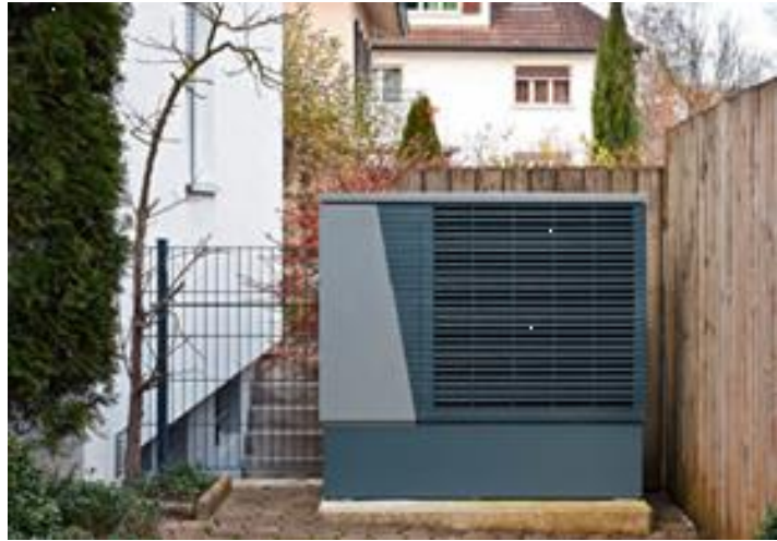
Bild: Aussen aufgestellte Luft/Wasser-Wärmepumpe
